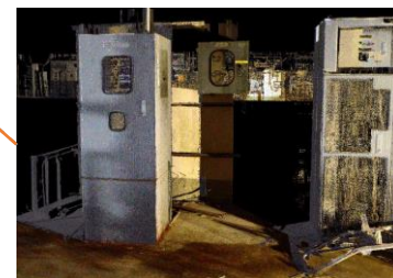
北側シェル壁点群
