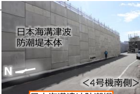
日本海溝津波防潮堤
