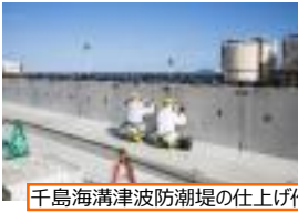
千島海溝津波防潮堤の仕上げ作業
