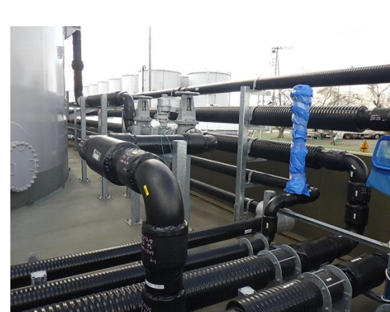
【移送配管敷設状況】(2026.2.3) （集水タンク堰内）
