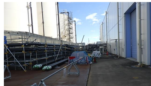
【移送配管敷設状況】(2026.2.3) （集水タンク～サブドレン他浄化設備）
