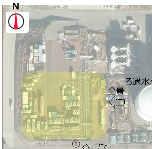
集水タンク設置エリア （黄色部）
