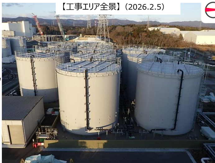
【工事エリア全景】(2026.2.5)
