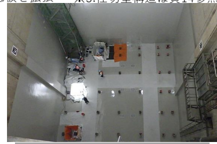
③ピットコンクリート補修後
