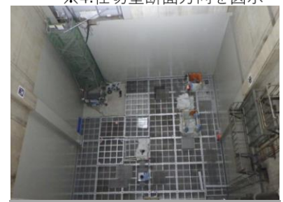
④ピット底板復旧中
