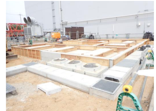
基礎設置作業の状況(2025年4月)
