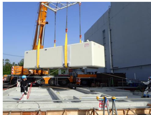
タンク設置作業の状況(2025年5月)
