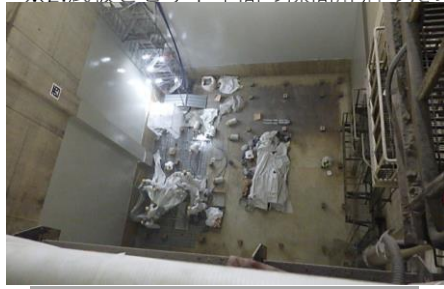
③ピットコンクリート補修中
