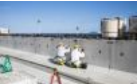
千島海溝津波防潮堤の仕上げ作業
