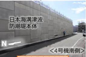
日本海溝津波防潮堤
