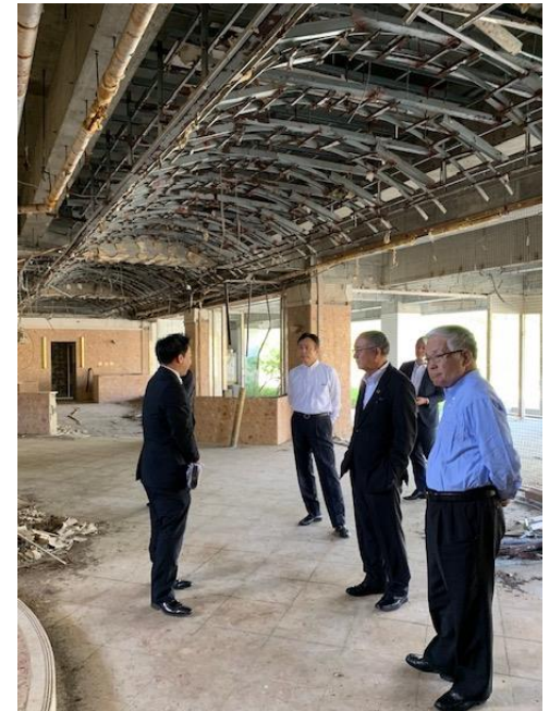
震災の遺構である「高野会館」を視察
