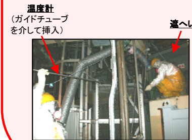
温度計設置の様子
