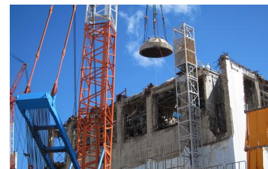
図3：大型機器撤去（原子炉圧力容器上蓋）の様子（9/13）
