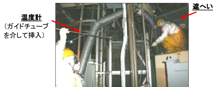
図1：2号機格納容器温度計設置の様子
