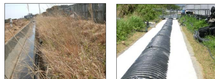
図2：排水路の暗渠化の様子
