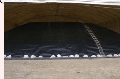
1槽目の様子（12/13） 遮水シート設置中
