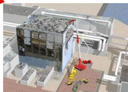
原子炉建屋上部のガレキ撤去
