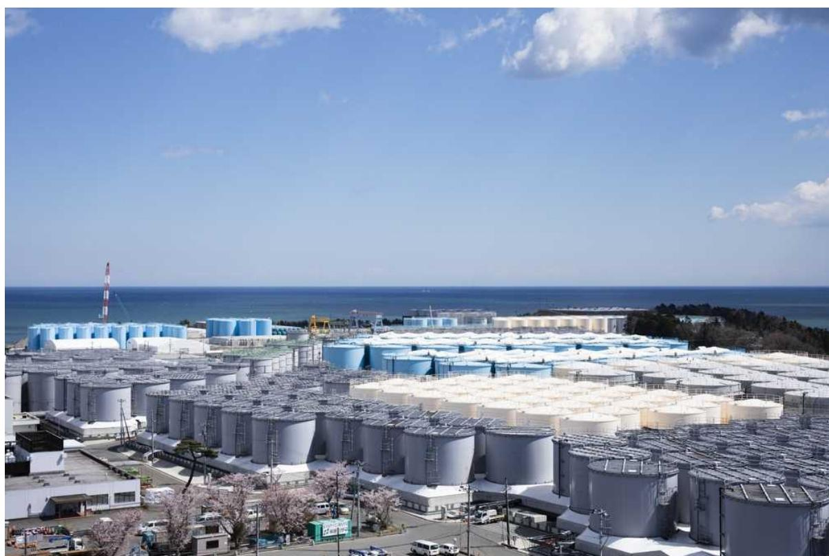
図I-4.福島第一原子力発電所におけるALPS処理水貯蔵タンク(出典: 東京電力HP)。
