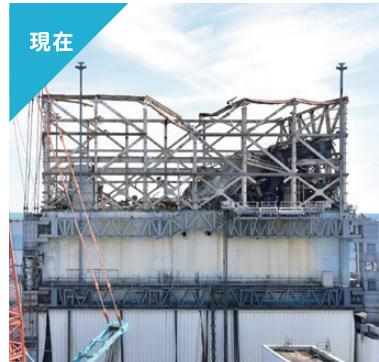
燃料取り出しに向け、ダストの飛散防止のために建屋をすっぽり覆う大型のカバーを設置する予定です。
