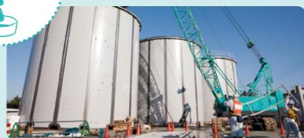
フランジ型から溶接型のタンクへ変更
