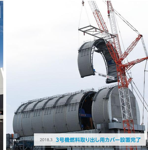
2018.3 **3号機燃料取り出し用カバー設置完了**
