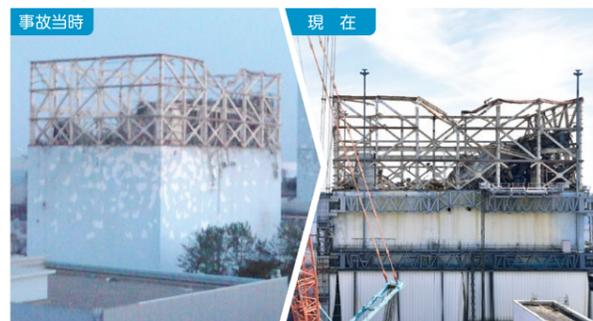
燃料取り出しに向け、ダストの飛散防止のために建屋をすっぽり覆う大型のカバーを設置する予定です。
