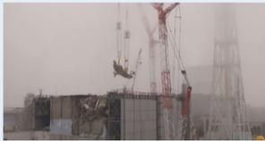
●3号機:使用済燃料プールから大型ガレキ(燃料交換機)の撤去完了(8月)
