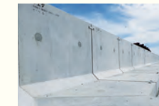
千島海溝津波防潮堤
