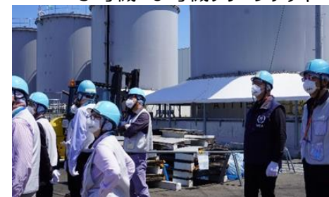
J9タンク解体エリア
