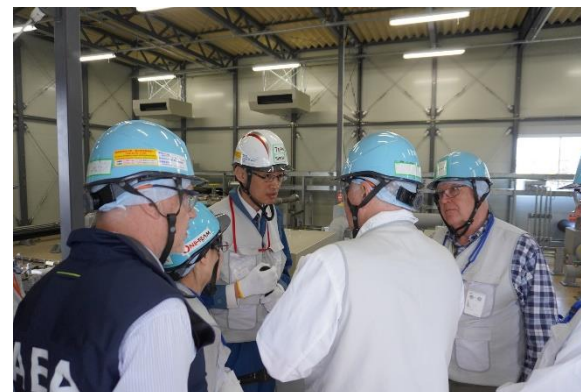
ALPS処理水移送建屋
