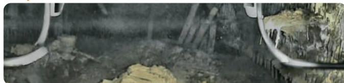
2023年3月1号機にて水中ロボットが原子炉格納容器を支える土台内を撮影
