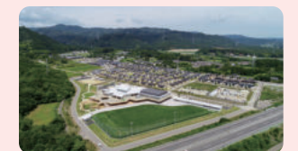
大熊町学び舎ゆめの森 竣工〈6月〉
