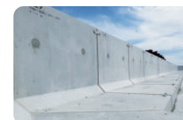
千島海溝津波防潮堤
