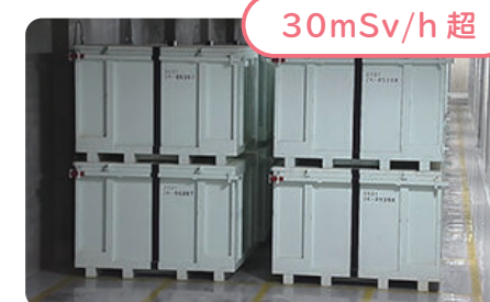
固体廃棄物貯蔵庫
