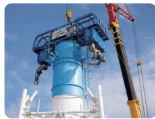
1、2号機: 排気筒の解体開始 (2020年5月完了)〈8月〉
