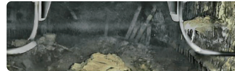
ペDESTAL内部のパノラマ写真
