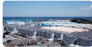
多核種除去設備等処理水の 溶接型タンクへの移送完了〈3月〉
