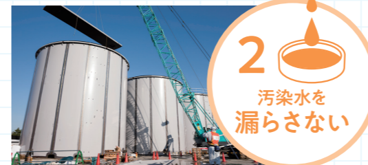
フランジ型から溶接型タンクへの置き換え
