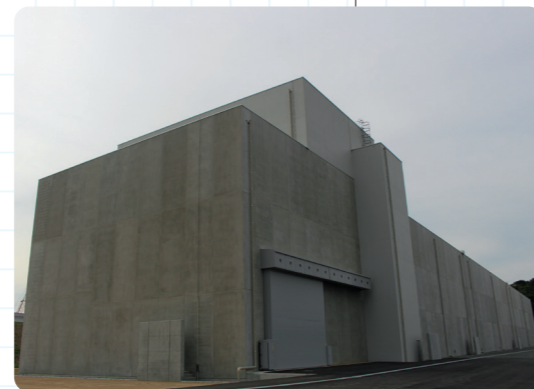
大型廃棄物保管庫第一棟 [2026年度運用開始予定]
