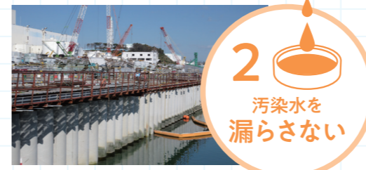
鋼鉄製の海側遮水壁を設置
