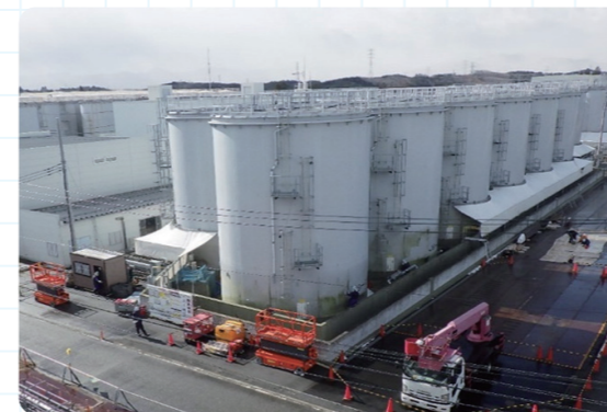
J9エリアタンク解体開始前
