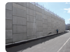
日本海溝津波対策防潮堤
