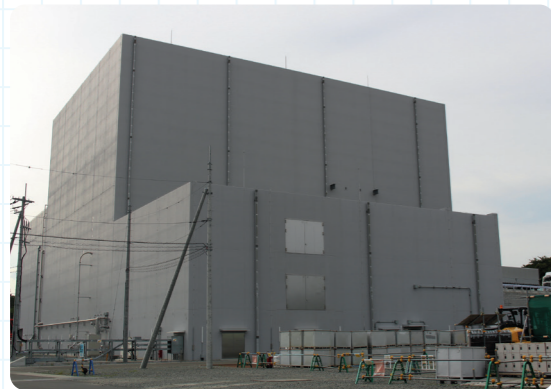
増設雑固体廃棄物焼却設備 [2022年5月運転開始]
