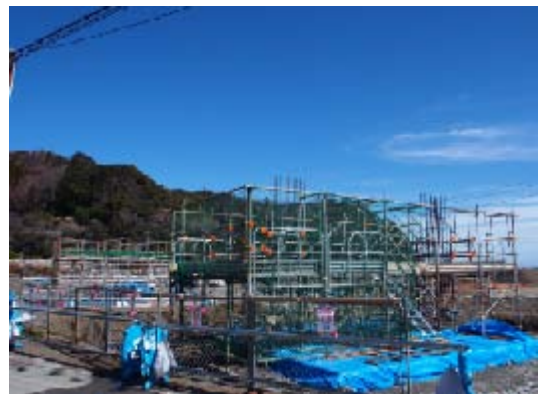
工事が進むと景色も大きく変わります。
