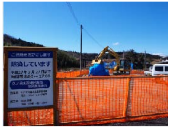
「除染しています」の作業看板
