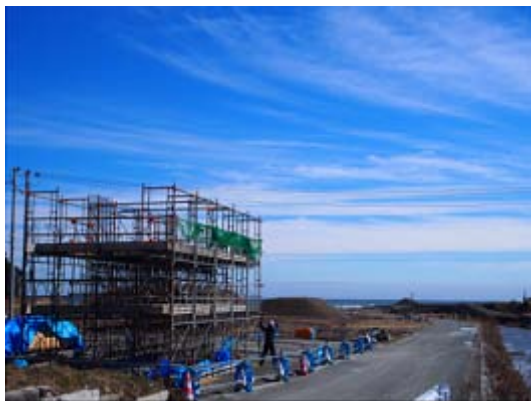
道路拡張と地盤かさ上げも同時に行われます。
