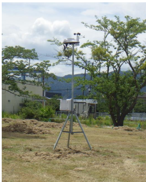
図 2-5 気象観測装置の設置状況
