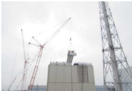
1号機建屋山側より撮影
