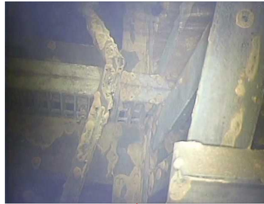
点検架台の支持構造物
