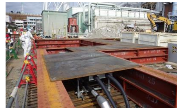
サブドレン養生状況
