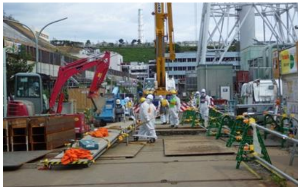
西側道路トレンチ設置状況
