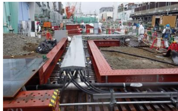
サブドレン養生状況
