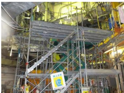
X100Bペネ下 (作業架台：高さ約4m)
