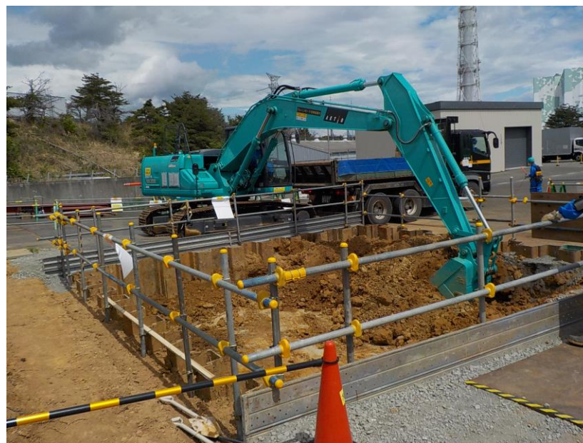
工事の状況（推進立坑掘削：5月11日現在）
