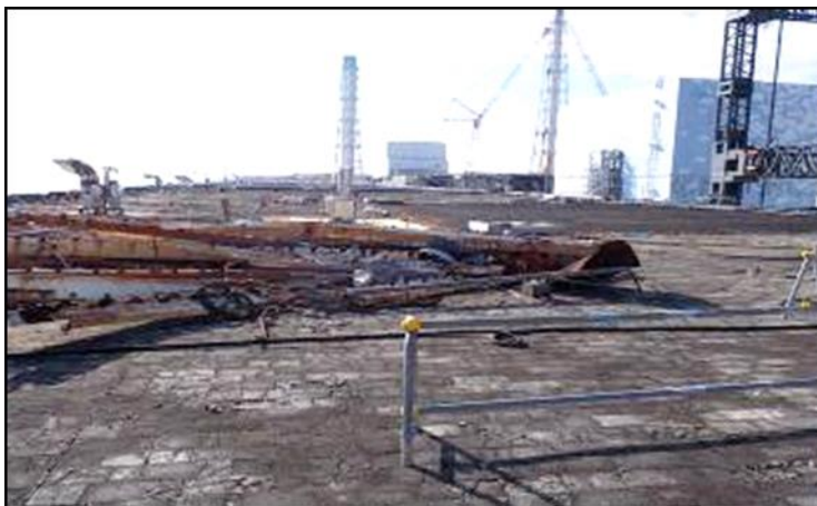
【施工前】1号機T/B屋根：1.2mSv/h
