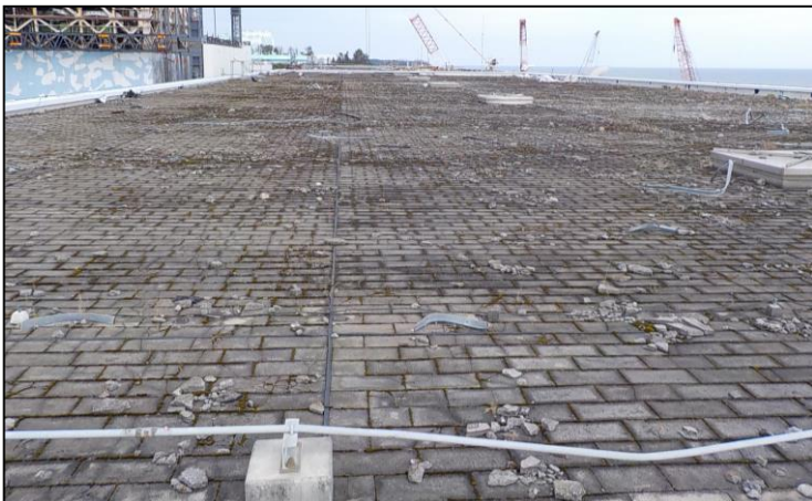
【施工前】2号機T/B屋根：0.7mSv/h
