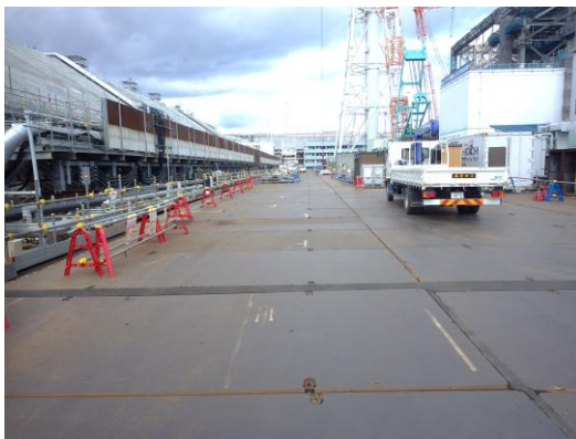
写真① 西側路盤整備完了
