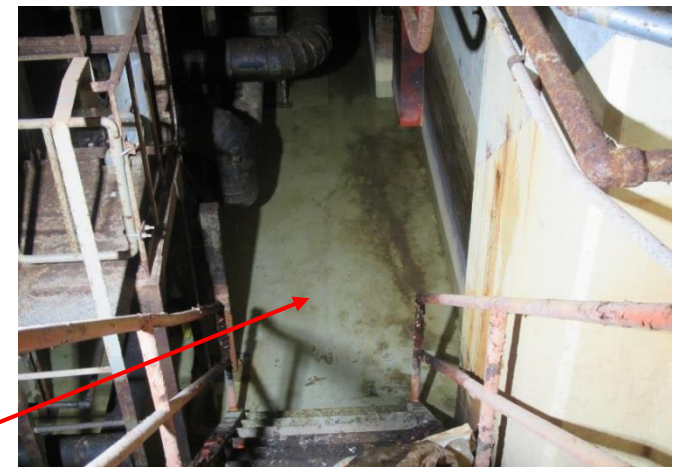
写真3：地下1階床面（南側）
