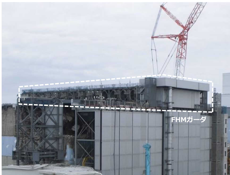
FHMガーダ建方状況（撮影日2017年5月10日）
