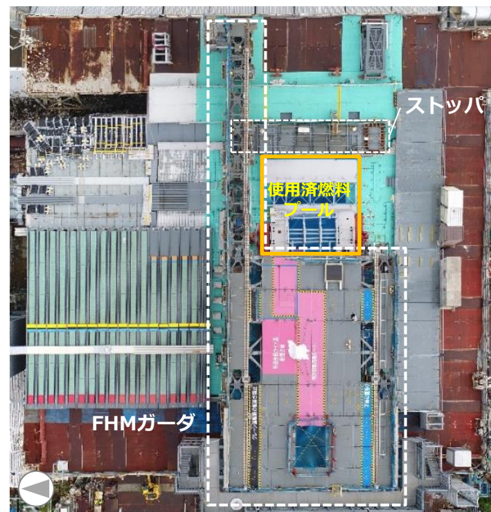
F H Mガーダ建方状況（撮影日2017年4月21日）
