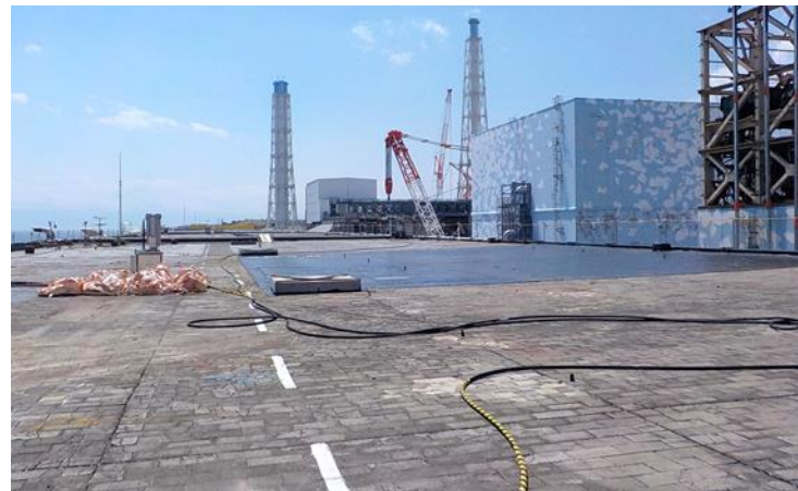
【現況】1号機T/B屋根（簡易防水工事中）：0.9mSv/h
