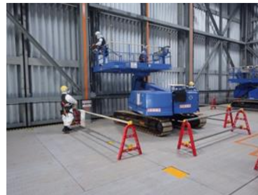
写真② 前室壁隙間塞ぎ作業状況
