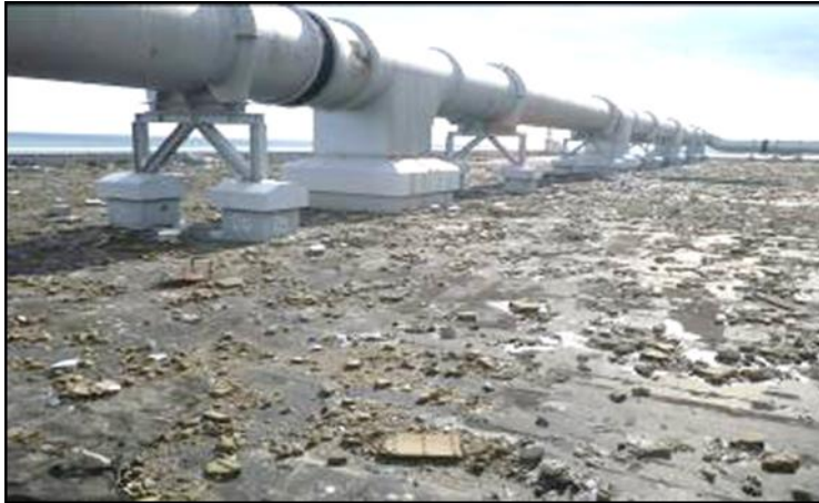
【施工前】4号機T/B屋根 : 0.5mSv/h
