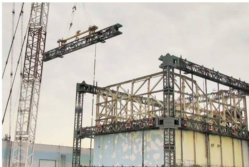
上段北梁取り外し（3/31）
