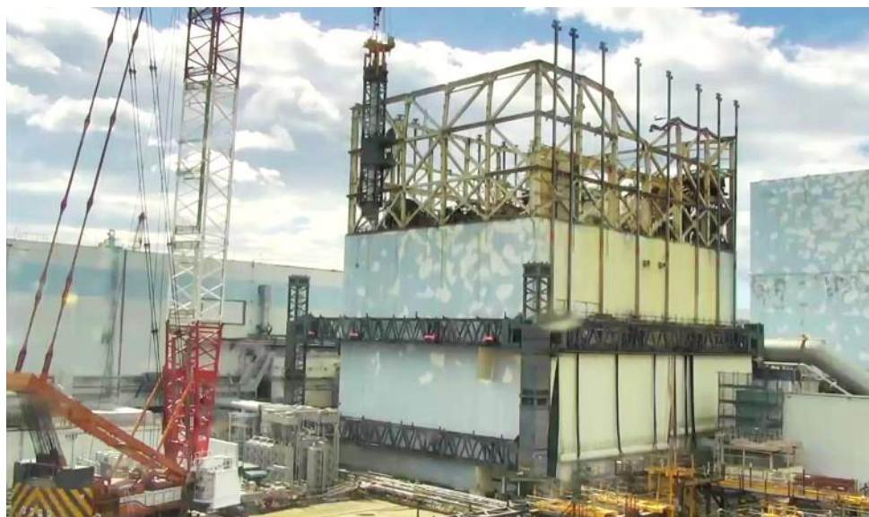
北西柱取り外し（5/11）
