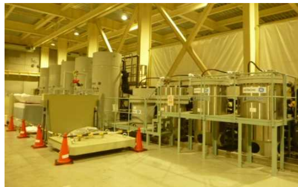
③サブドレン他浄化設備
