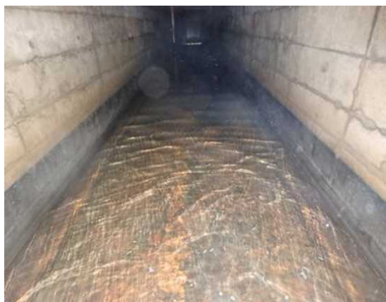
<K排水路清掃状況>
