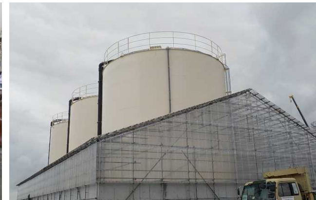
②集水タンク (3基)
