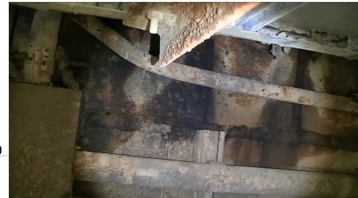
流入箇所下部の写真
