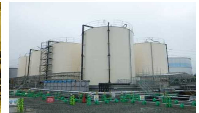
④一時貯水タンク (7基)
