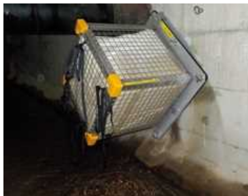
枝管への浄化材設置状況
