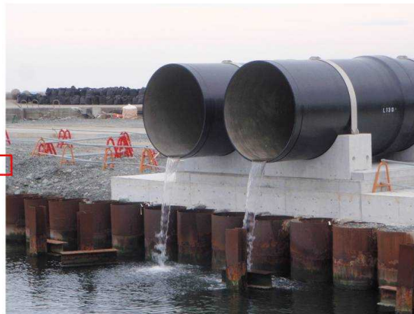
付替後排水路出口
