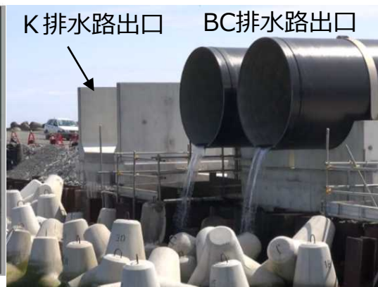
付替後排水路出口
