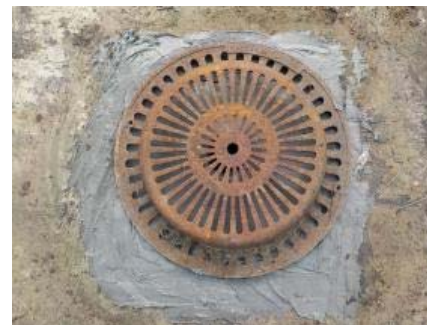
②ルーフドレン改修完了
