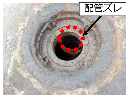
②ルーフドレン改修着手前
