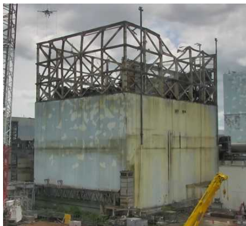
1号機原子炉建屋全景（2021年5月26日時点）
