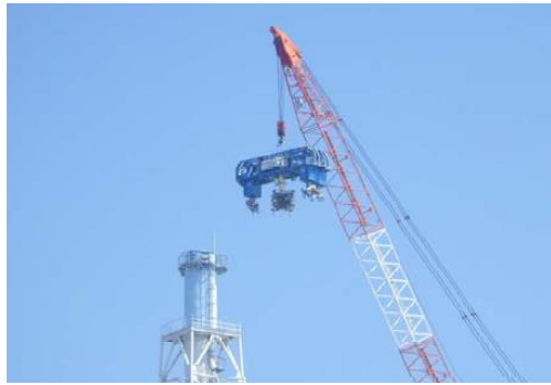
図5 1/2号機排気筒の解体開始（2019年8月）
