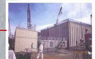
使用済吸着塔一時保管施設
