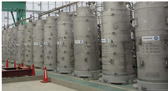
図3 高性能多核種除去設備
