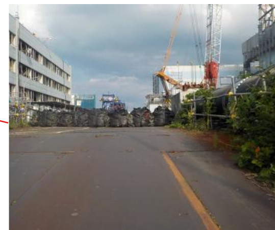
土嚢設置状況
