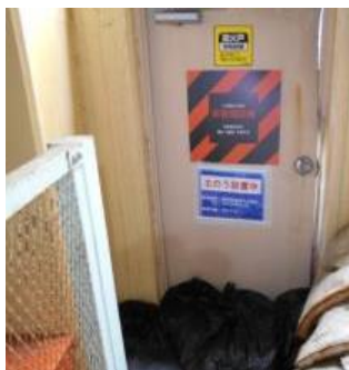
開口部への土のう設置例
