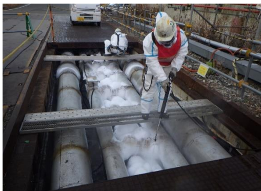
【冬季における路下部の氷着状況】 (写真は7BLK-H3の融氷作業中)
