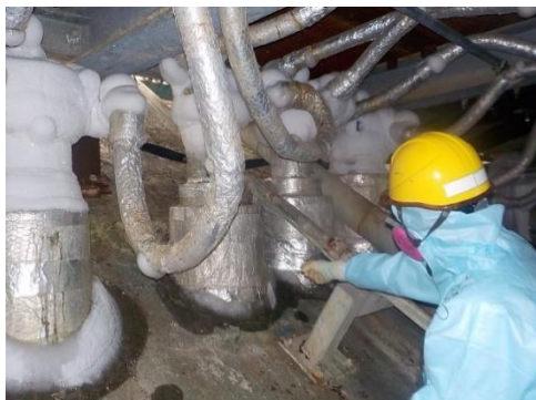
【地上部の目視調査実施状況】 (5BLK-H4)
