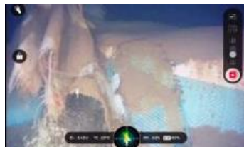
破損している土囊(現在)
