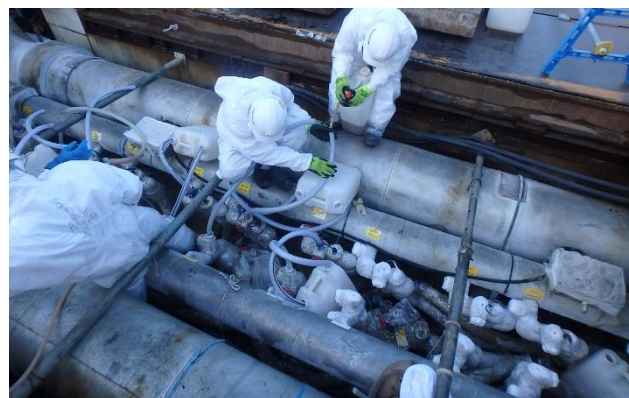
【加圧試験実施状況】
