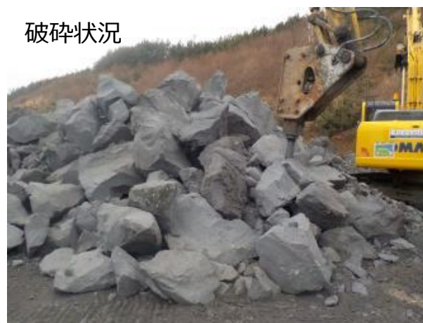
写真②：人工地盤材料製造状況
