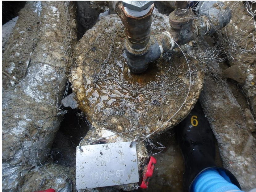
加圧試験前の状況 1870-6T
