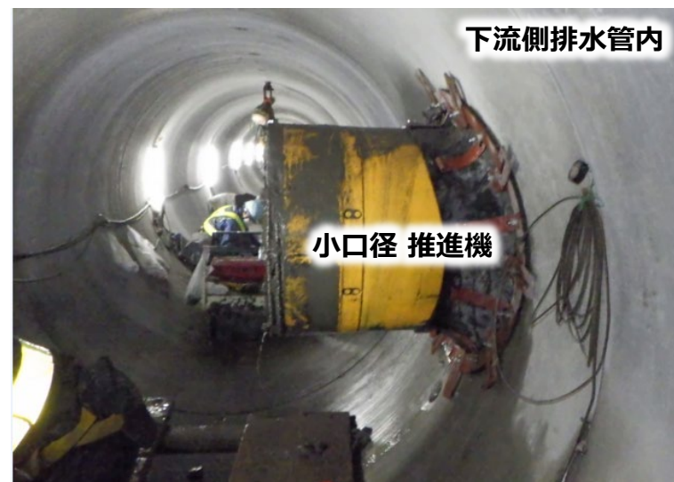
写真⑤ 小口径_本管接続
