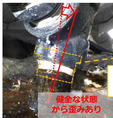
①凍結管継手部の目視確認
