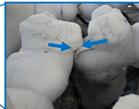
③漏えい箇所周辺の現場状況（凍結管着氷時）
