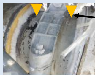
配管レベル計測箇所
