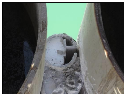
【継手部写真（モルタル充填後）】
