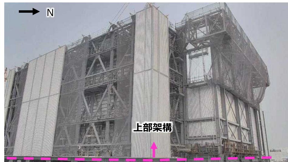
現場状況（南東面） （撮影：2025年3月26日）
