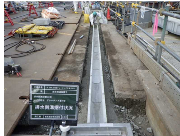
施工中：雨水排水側溝設置
