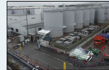
＜解体状況(4月21日)＞
