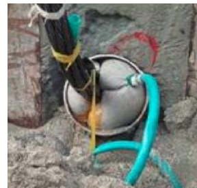
グランドアンカー口元止水
