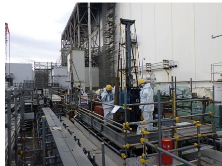
写真1 ボーリング状況
