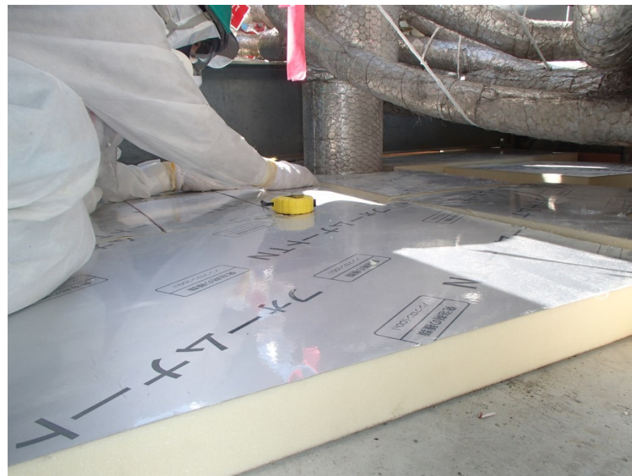
写真⑦ 7BLK断熱材敷設
