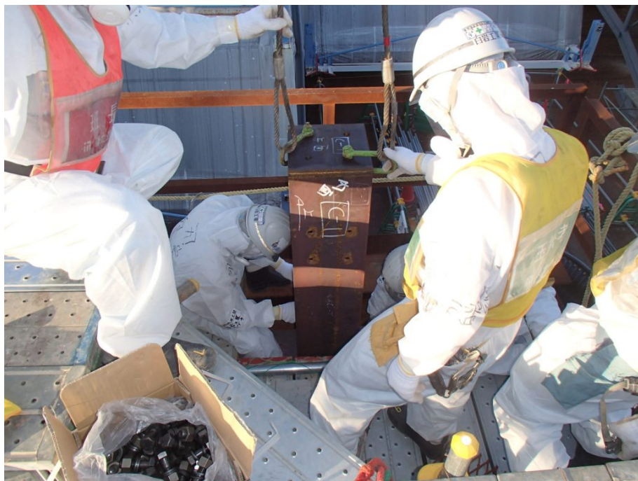
写真① 1BLK補助工法 架台建込
