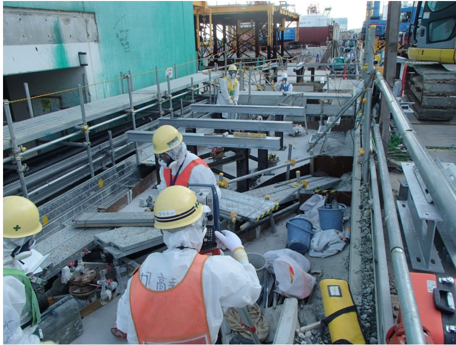
写真⑬-1 13BLK地上配管 架台設置
