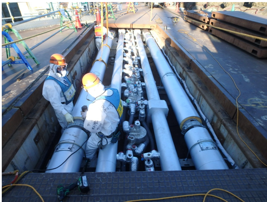
写真⑪ 11BLK地上配管設置
