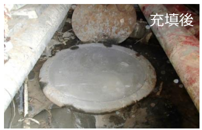
2号機取水電源ケーブルトレンチ貫通箇所 止水状況 (写真②), 充填状況 (写真③)
