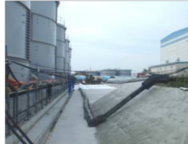
浸透防止工事後の状況
