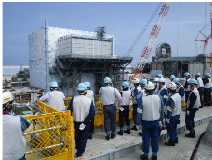
1～4号機俯瞰(2,3号機)
