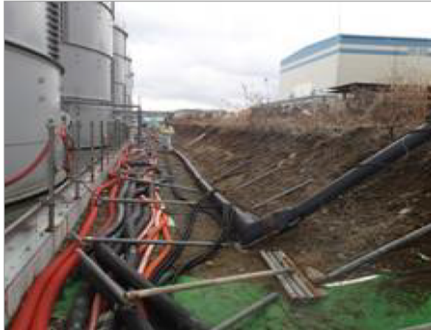
＜参考＞ 浸透防止工事前の状況
