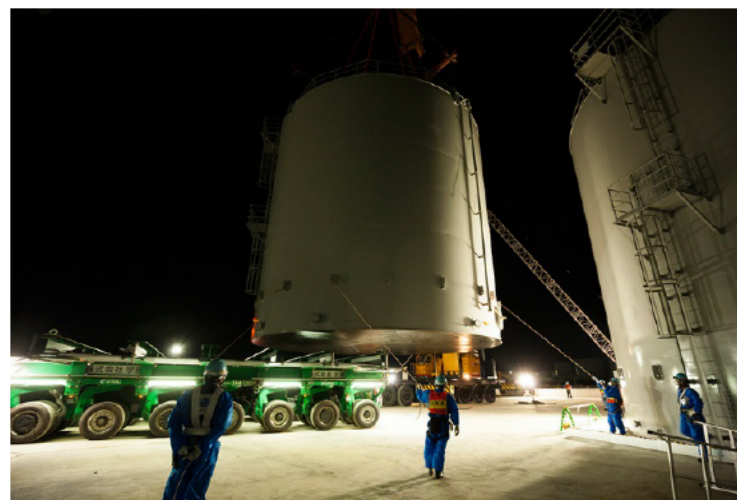
1200m 3 級溶接タンク（完成型タンク輸送の状況）
