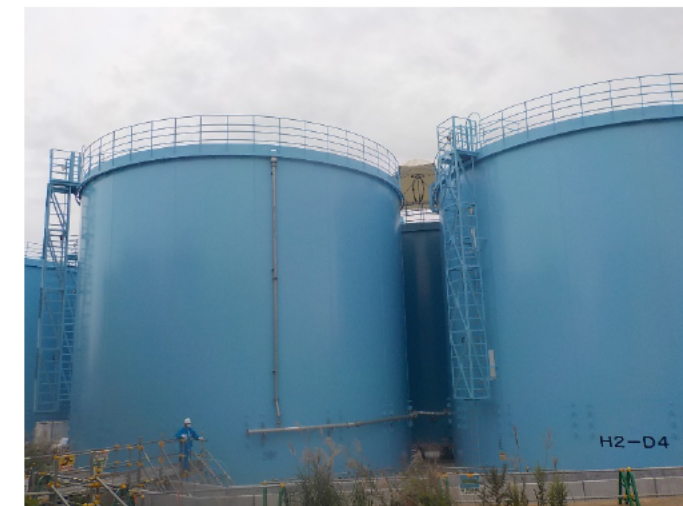
2400m 3 級溶接タンク
