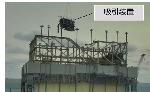
ガレキ撤去の作業状況 (2018年1月22日)
