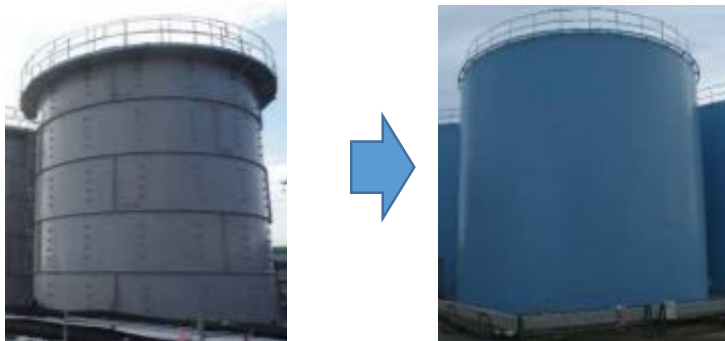
【溶接型タンクへの切替え】
