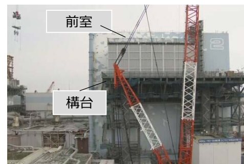
原子炉建屋西側の構台と前室
