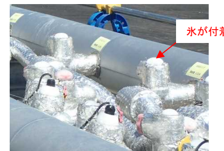
陸側遮水壁 凍結開始後の状況
