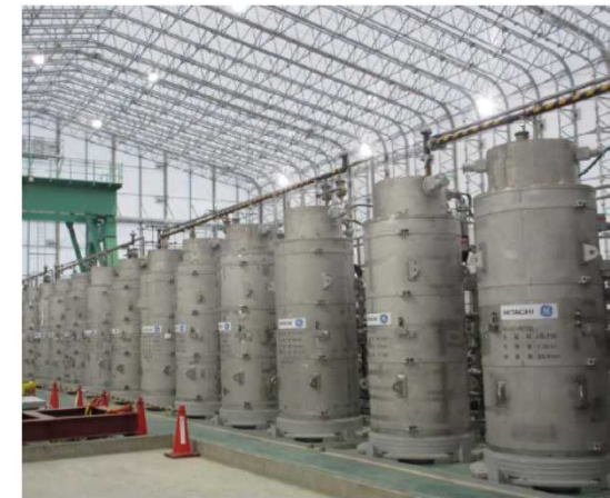
高性能多核種除去設備 吸着塔
