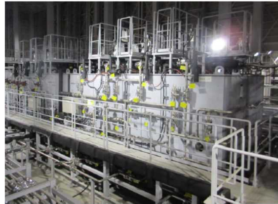
増設多核種除去設備 吸着塔
