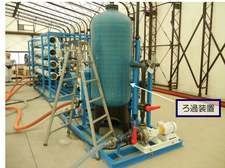
<淡水化装置（ろ過装置）>
