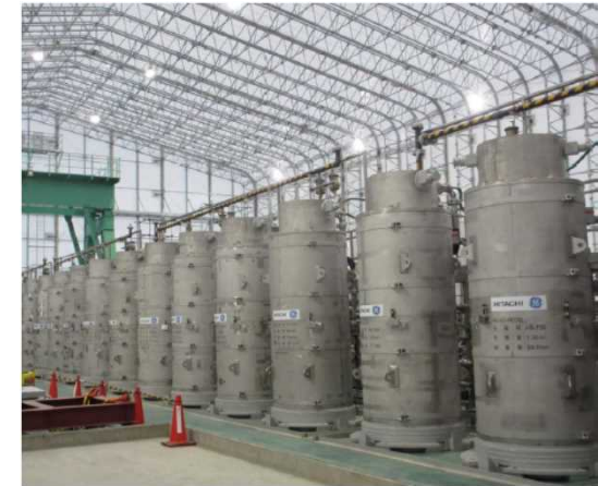
高性能多核種除去設備 吸着塔
