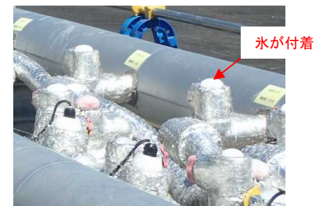
陸側遮水壁 凍結開始後の状況
