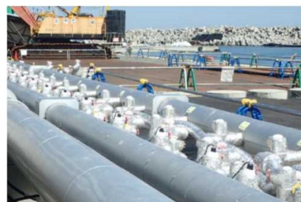
陸側遮水壁 凍結開始後の状況
