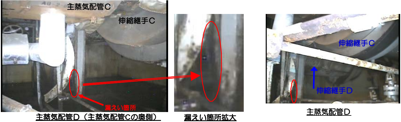
図5：3号機主蒸気隔離弁室内調査状況
