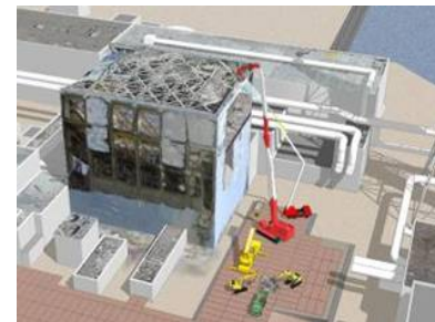
原子炉建屋上部のガレキ撤去
