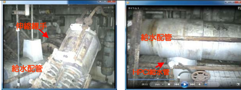
給水配管B周辺
