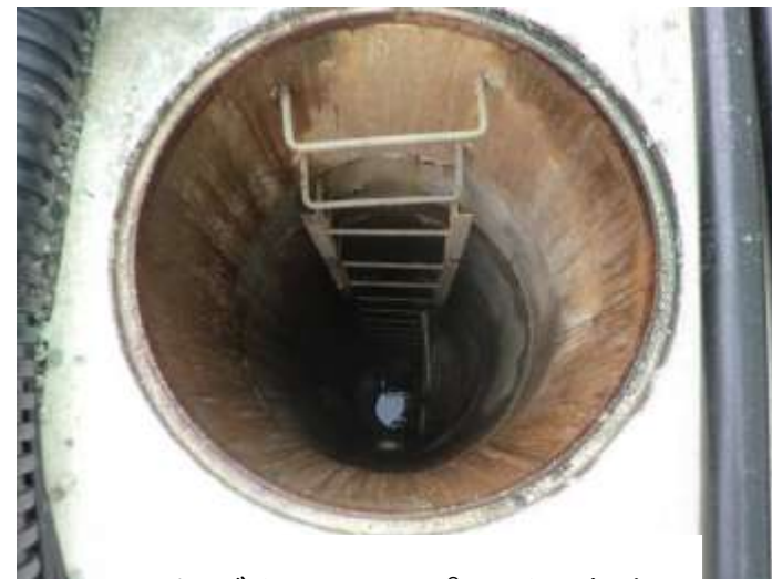
サブドレンピット内部
