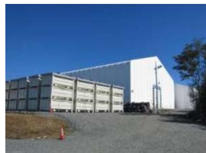
ガレキの保管エリア (テントと容器)
