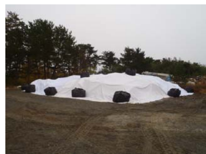
屋外集積のうち、表面線量率100 \mu Sv/hをこえるガレキは難燃シートによる養生
