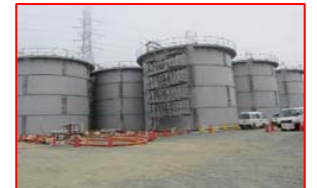
鋼製丸型タンク (淡水、RO廃液)
