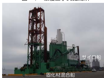
写真-1 作業船団 (小名浜港にて撮影)
