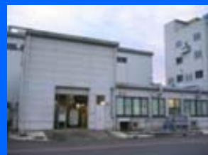
水素製造試験施設
