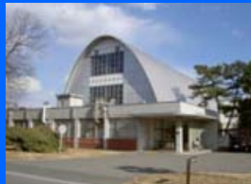
60 Co第1照射棟
