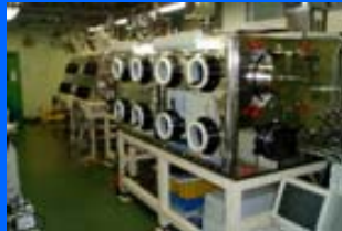
再処理技術開発センター 分析施設
