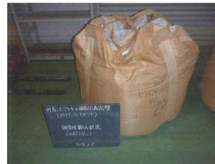
状況写真3 材料搬入状況(細骨材：山砂)
