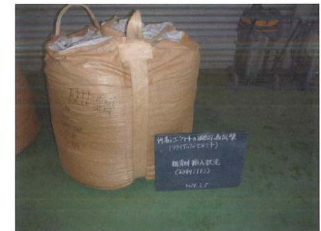
状況写真4 材料搬入状況(粗骨材：砂利)
