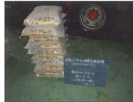
状況写真1 材料搬入状況(普通ポルトランドセメント)
