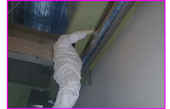
④ダクト撤去
