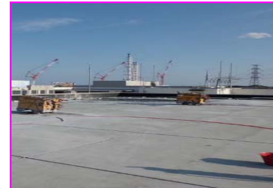
⑤屋上コンクリート撤去
