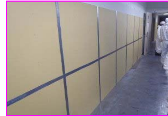
①内壁への鉛ボード張り
