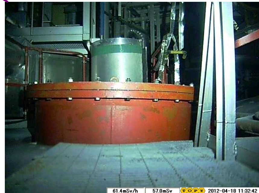
南東S/Cマンホール
